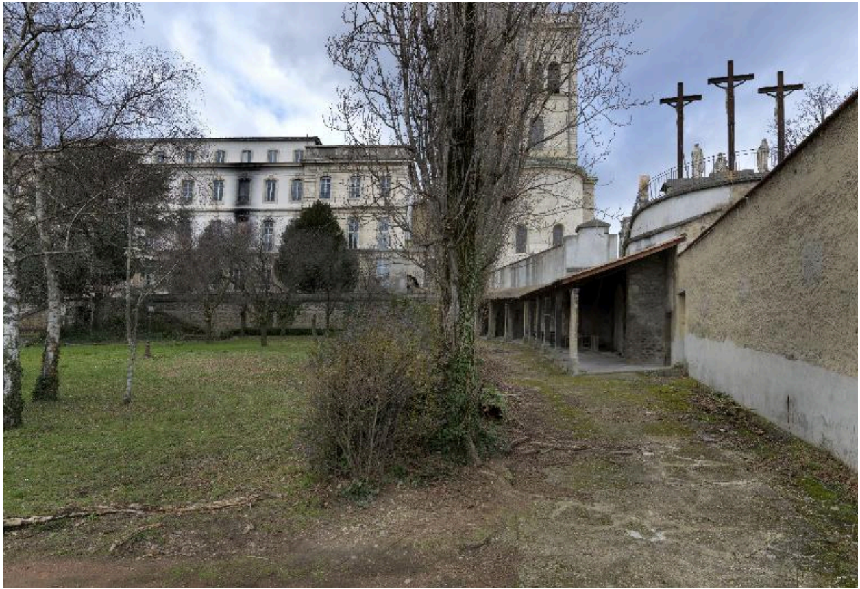
Prieuré, le jardin : le portique, vue de situation, au nord du jardin
