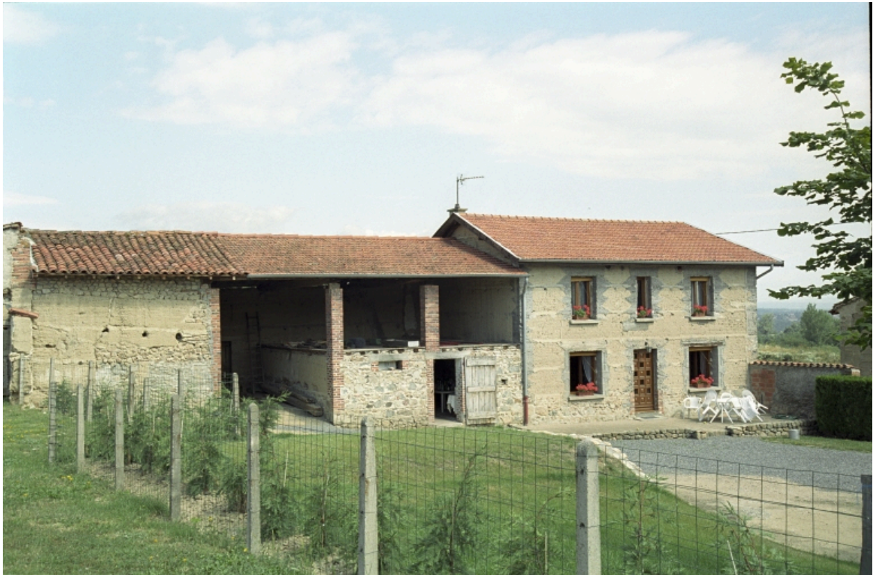
Marcoux, la Bruyette, ferme (1986 ZD 43). Pisé de terre avec renforts de béton ou mâchefer (milieu 20e siècle, vers 1940).
