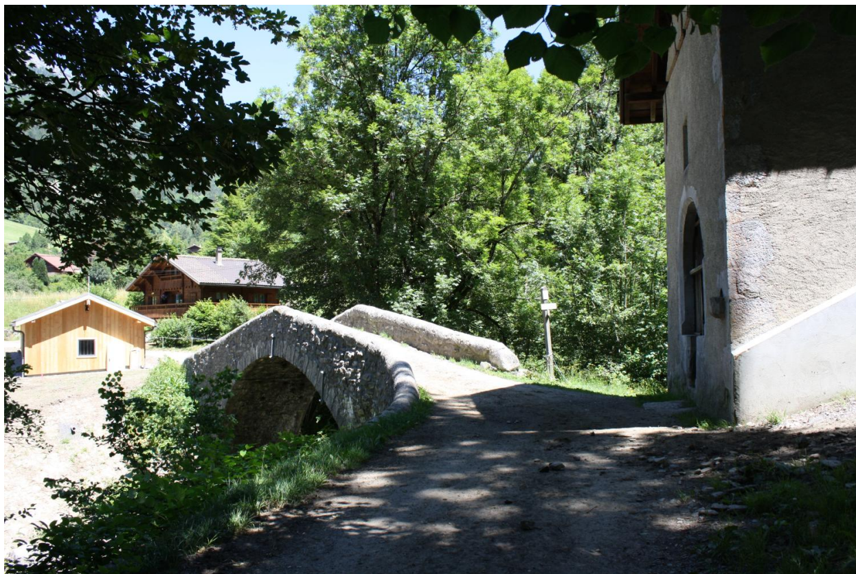
Vue générale du pont de la Vacherie
