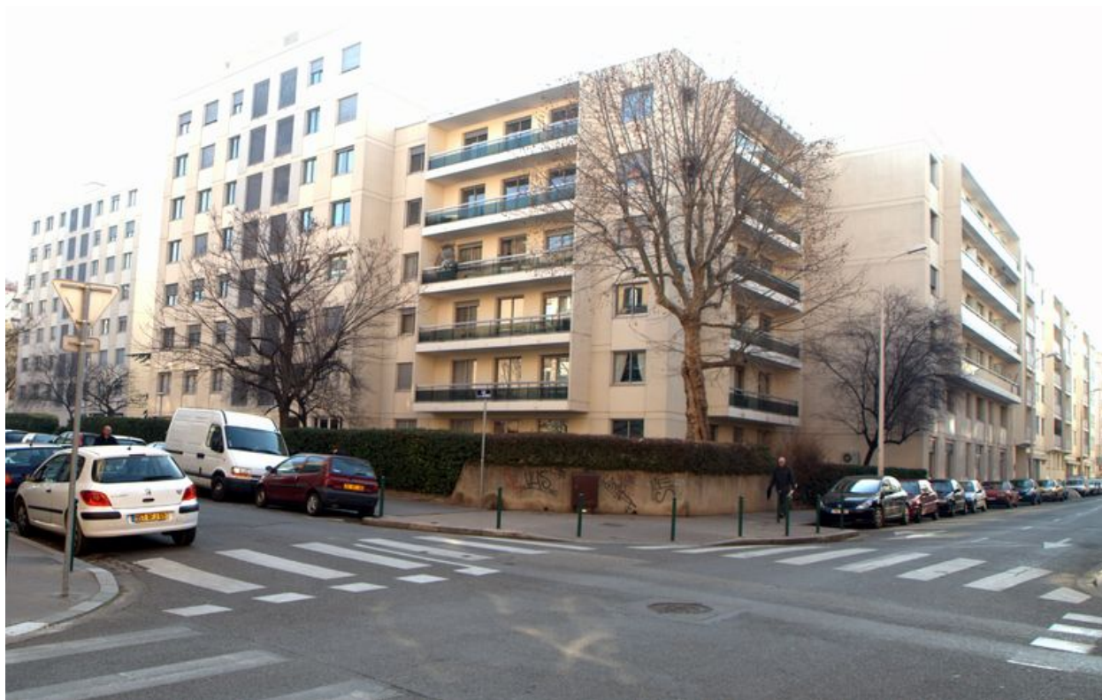
Elévations sur rue, angle rue Nicolaï et rue Jules-Brunard
