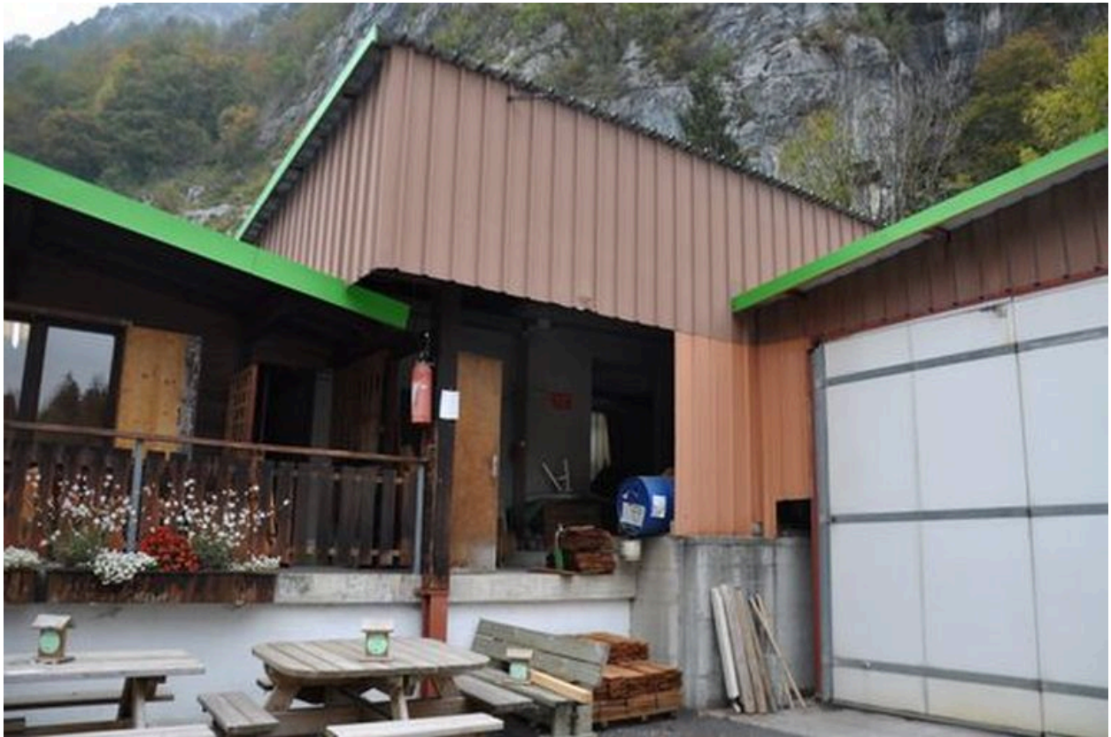
Entrée de la centrale hydroélectrique
