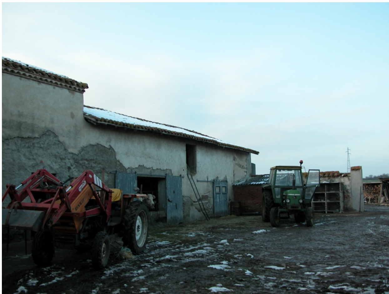
Vue de la grange-étable dans le prolongement du logis.
