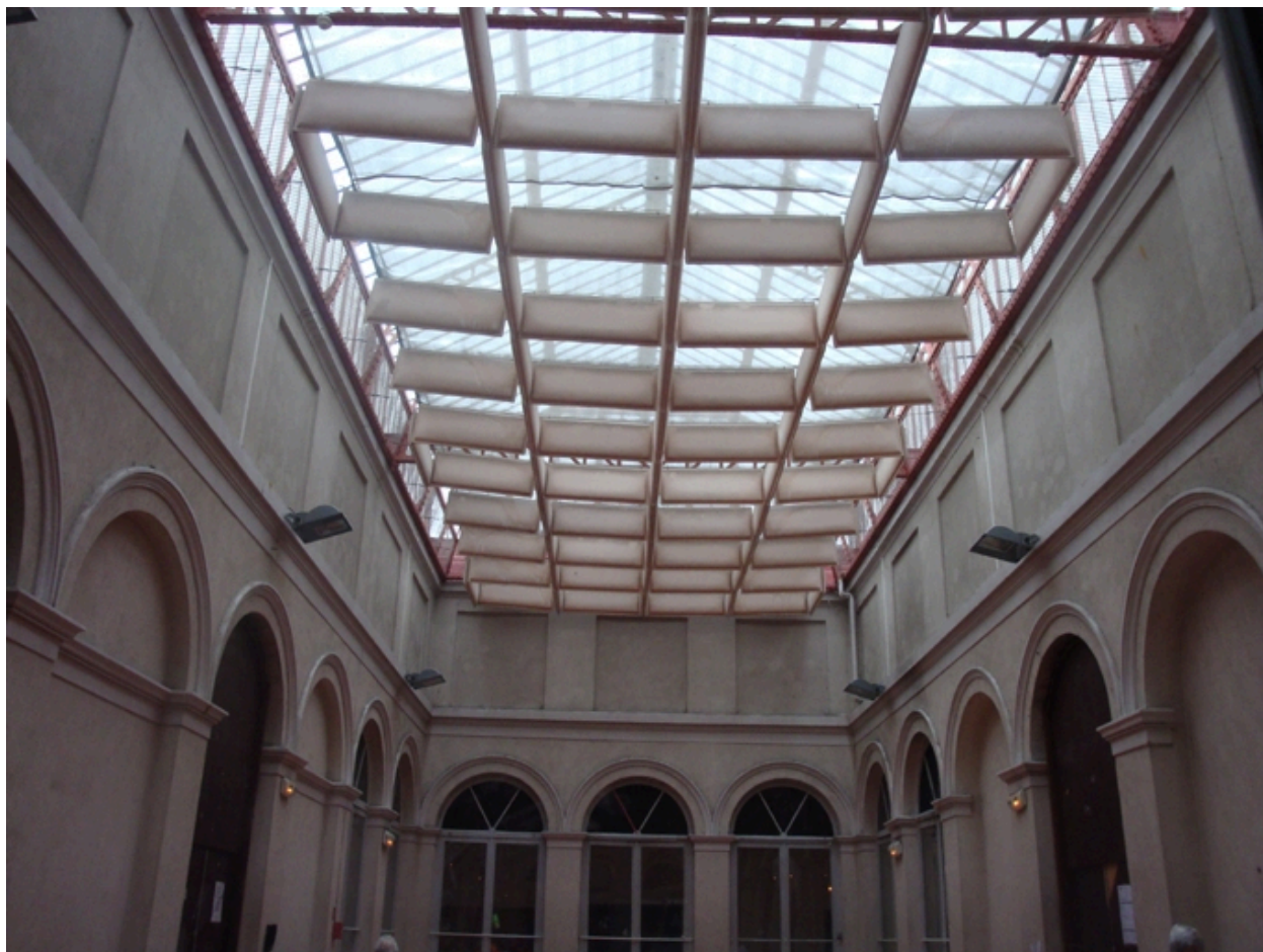
Vue hall sous verrière, 3ème étage
