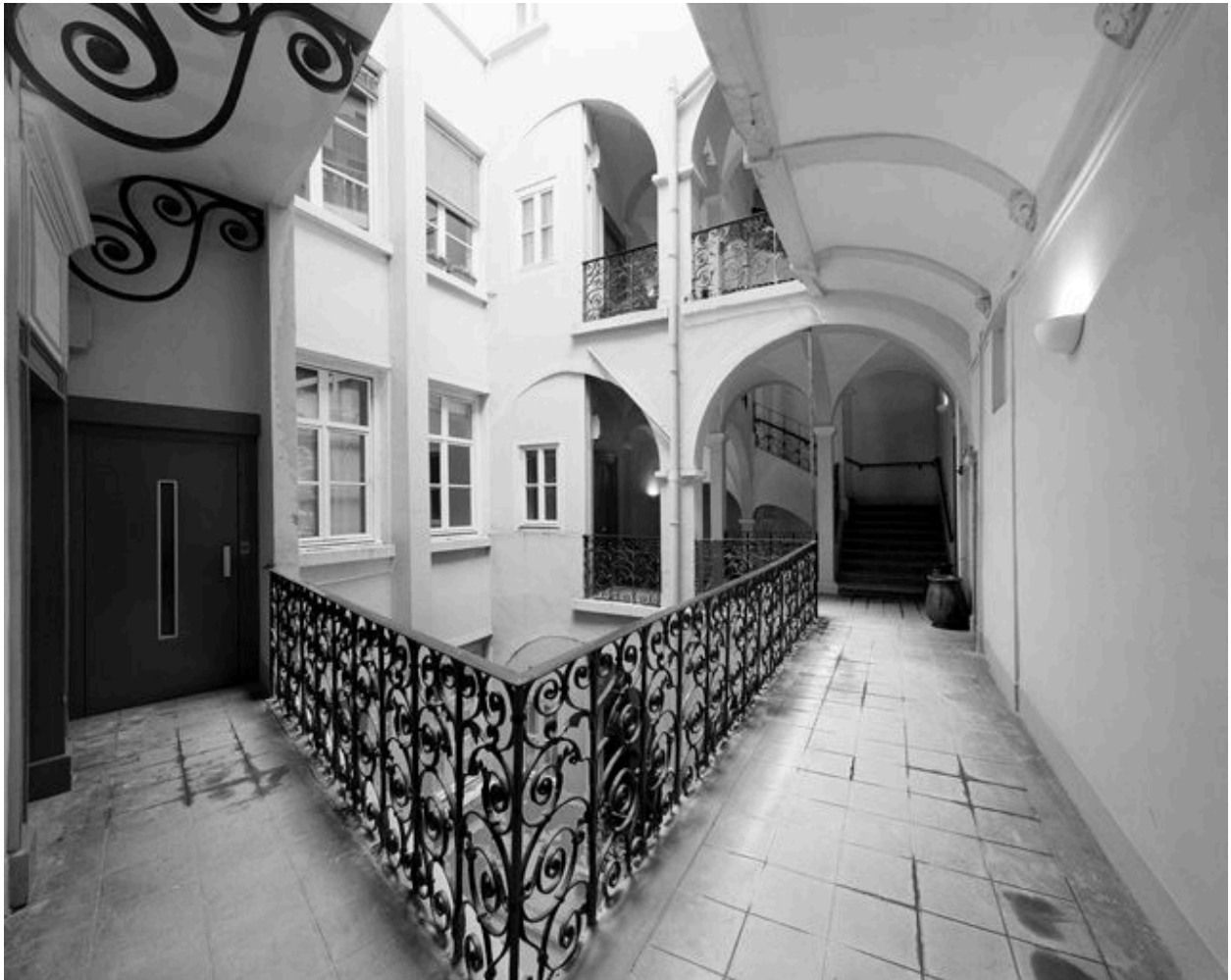
Vue générale des coursières du 2e étage depuis l'angle entre le corps arrière (à gauche) avec la coursière de liaison (à droite)
