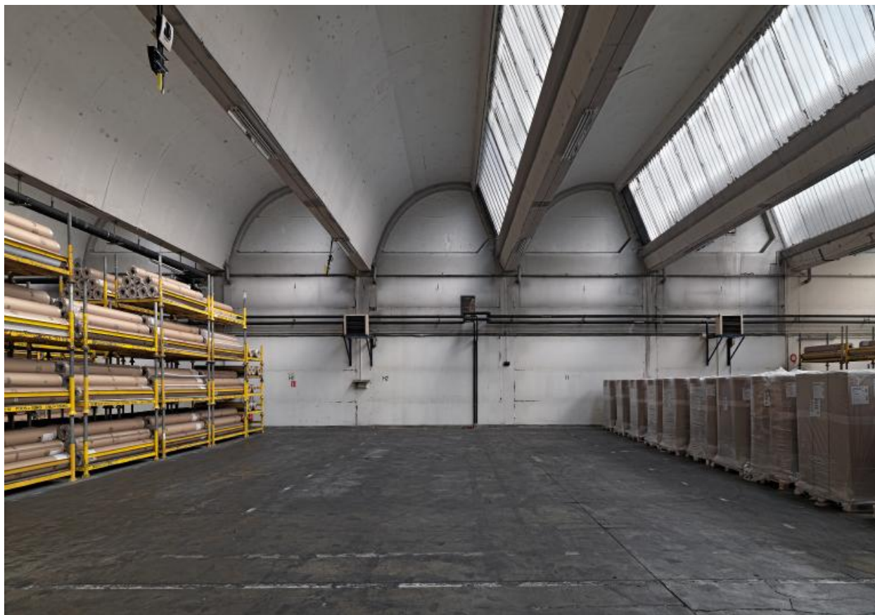
Détail sheds en béton
