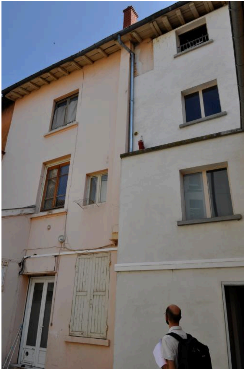
Elévation sur cour, vue partielle
