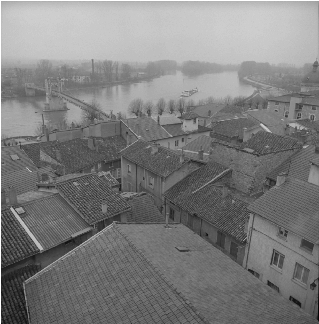
Vue sur les toits et la passerelle, quartier sud-ouest.
