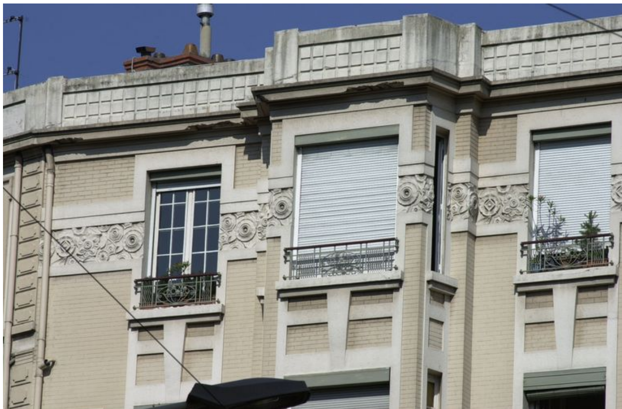
Détail de la frise du dernier étage
