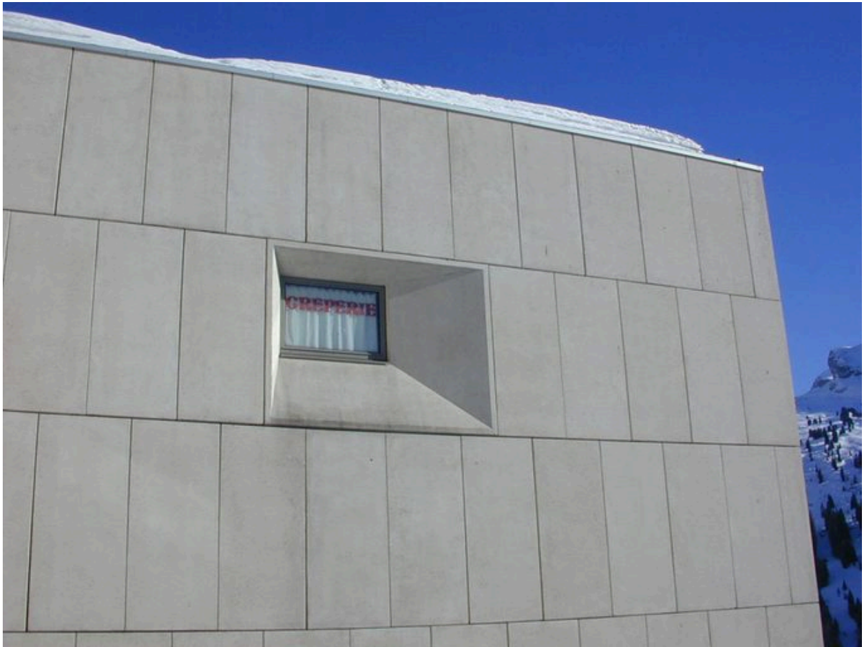
Détail d'une baie à l'étage, façade nord
