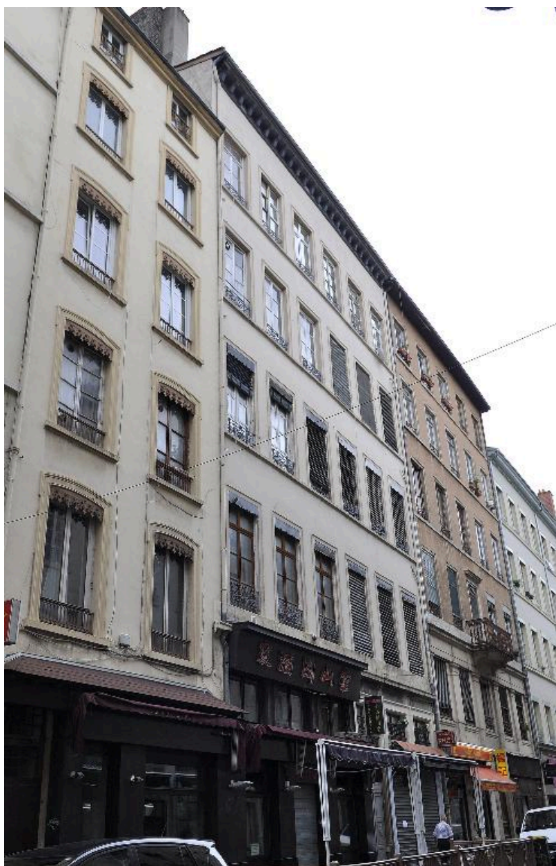
Vue générale de l'élévation sur rue
