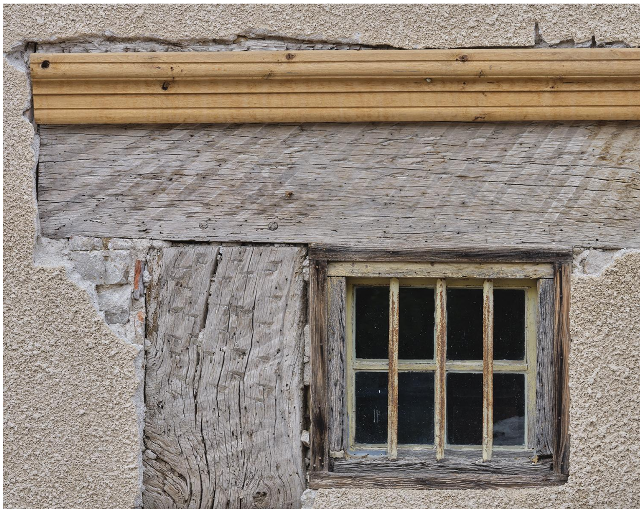
Elévation sud de la maison, angle supérieur gauche des poutres en bois encadrant une baie du rez-de-chaussée.
