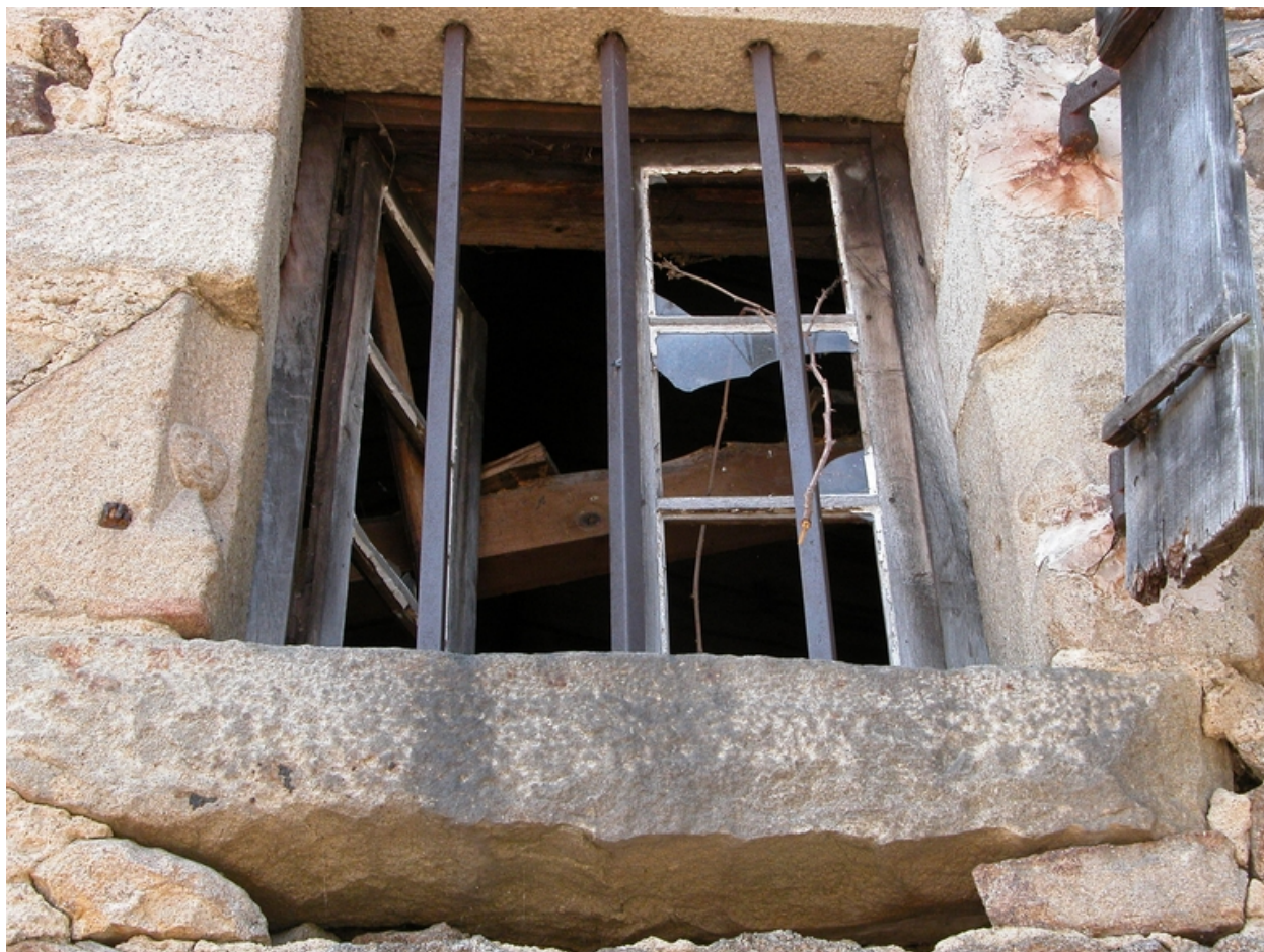
Détail d'une fenêtre (encadrement en remploi).
