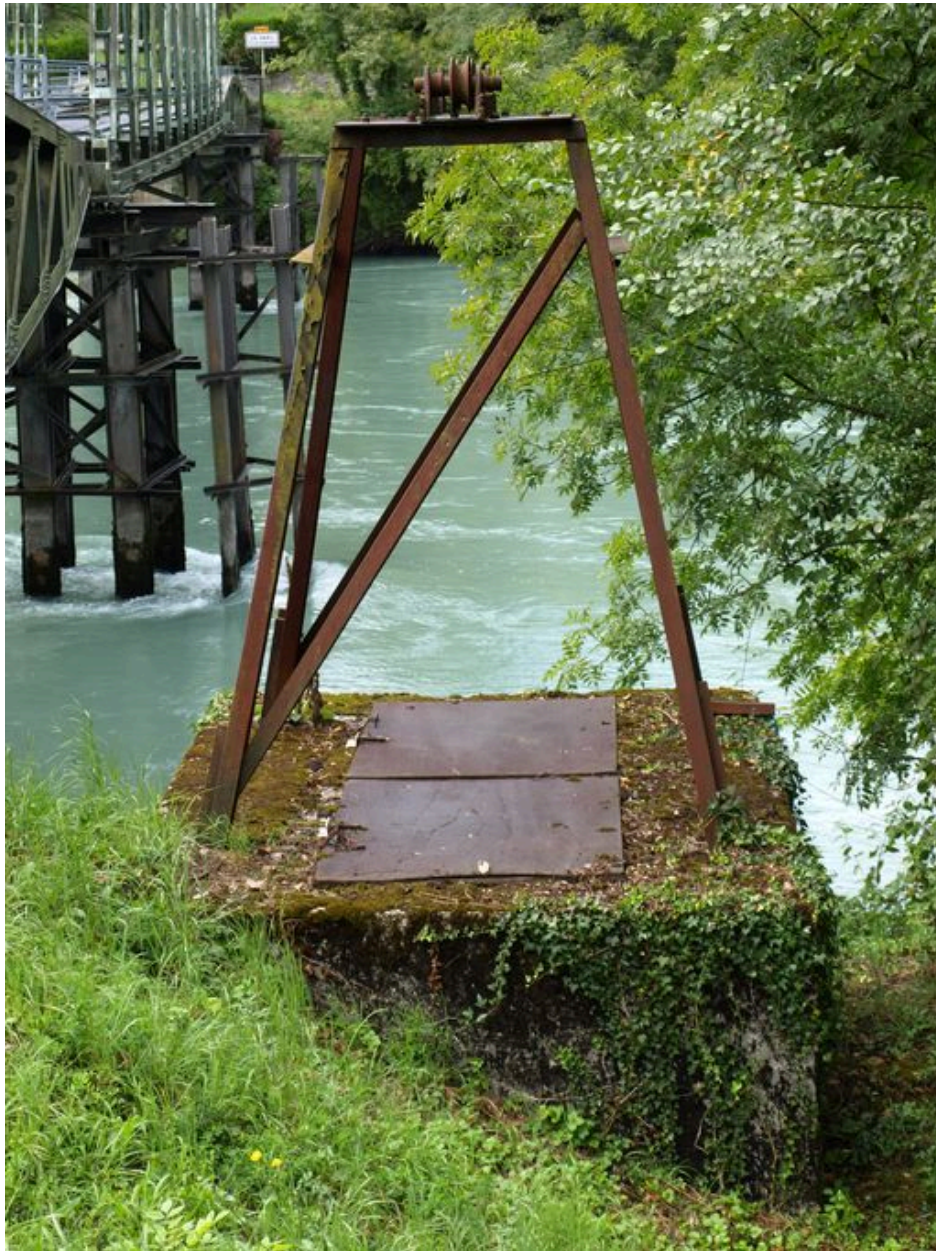
Treuil, vue partielle (rive gauche)
