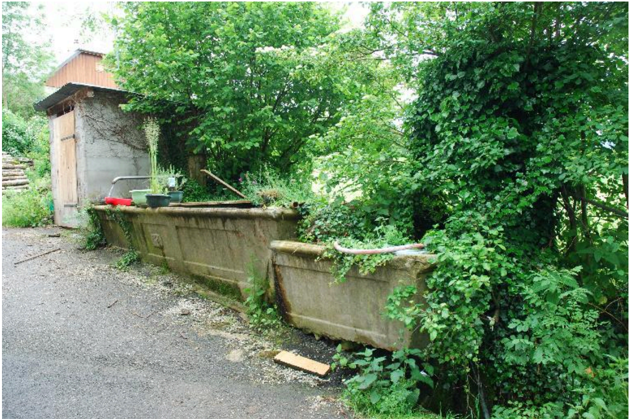
Vue d'ensemble des deux bassins situés au-devant de la ferme.
