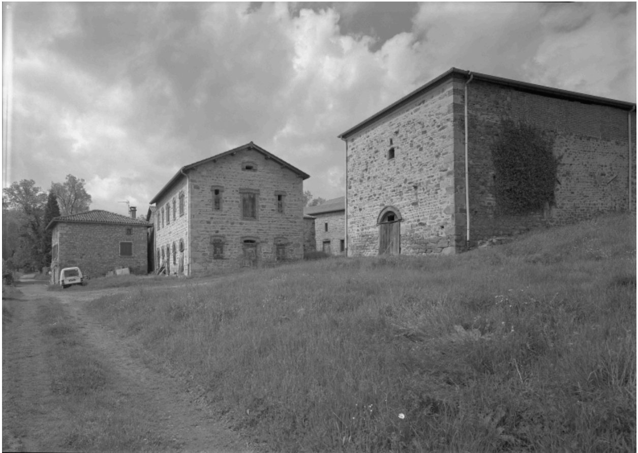
Vue d'ensemble d'une partie des communs (bâtiment à droite sur la photo), écuries à cheval et étables.
