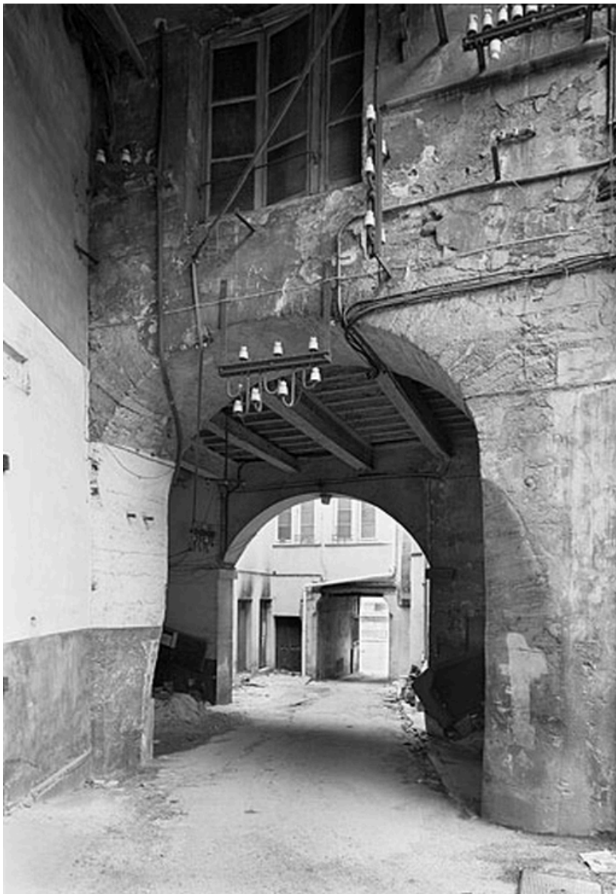
Corps de passage, vue ouest.
