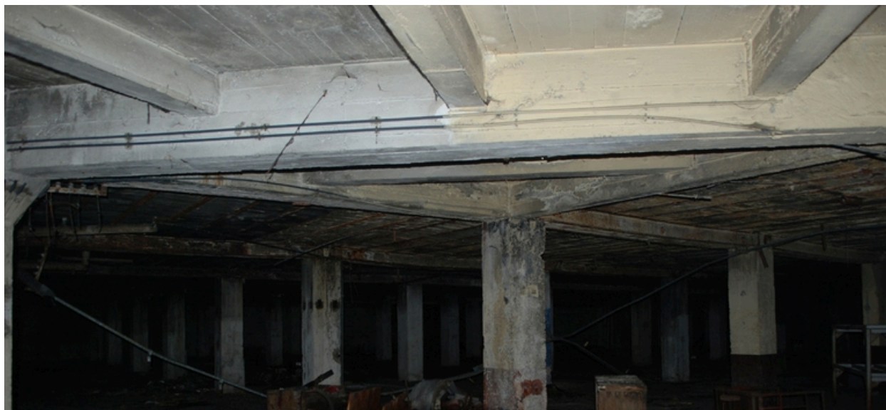
Détail ensemble de piliers béton en rez-de-chaussée
