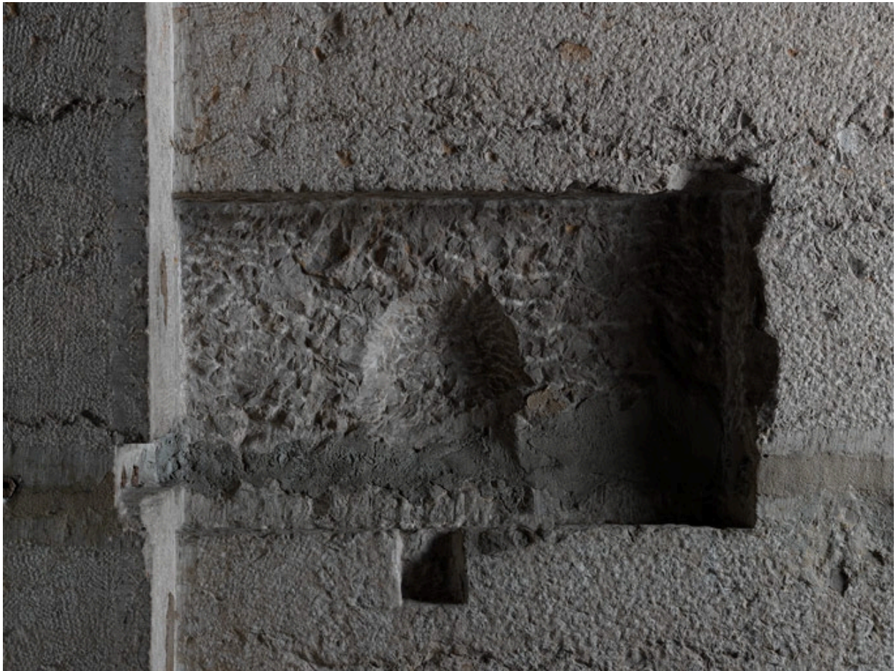
Détail de l'emplacement de la serrure dans l'ébrasement intérieur de la porte
