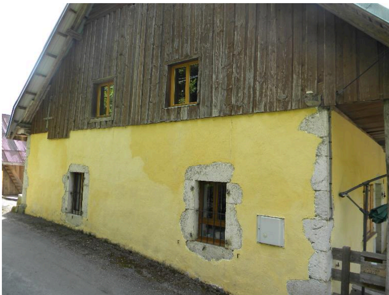
Vue du mur pignon ouest d'une ancienne maison (2008 B5 860)
