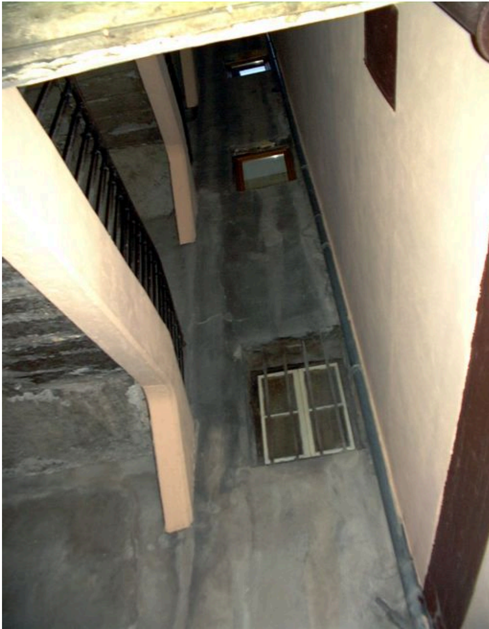
Escalier commun aux 12 rue Ferrachat et 9 rue Bellière, élévation sur cour du corps de bâtiment est
