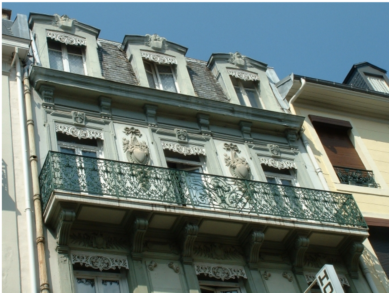
Détail de la façade
