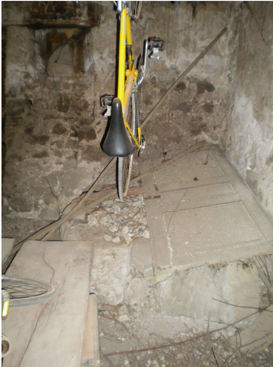
Vue des restes d'un puits comblé dans une pièce donnant au nord.
