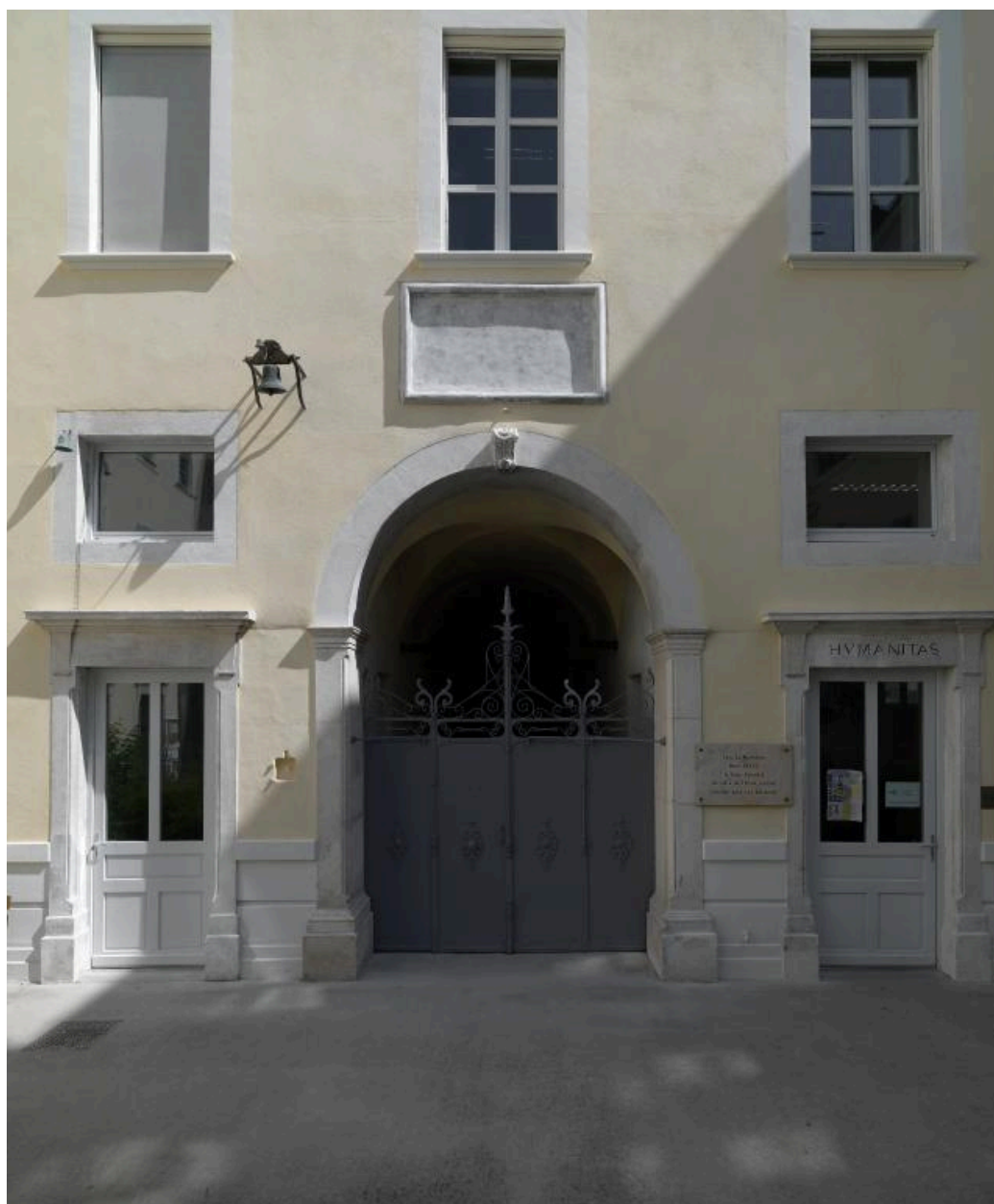
Corps de bâtiment nord : portail sur cour, ancienne entrée principale du lycée
