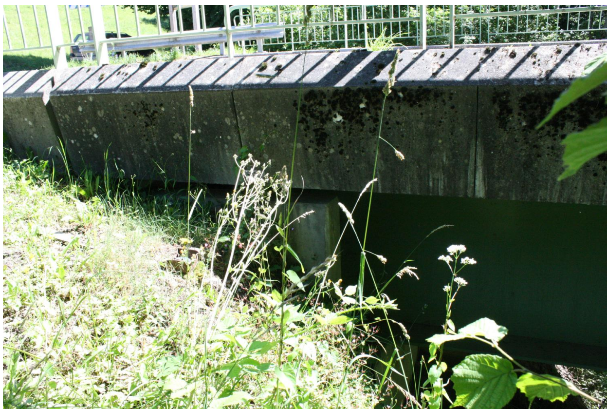
Grand pont de la scierie, détails culée et plinthe
