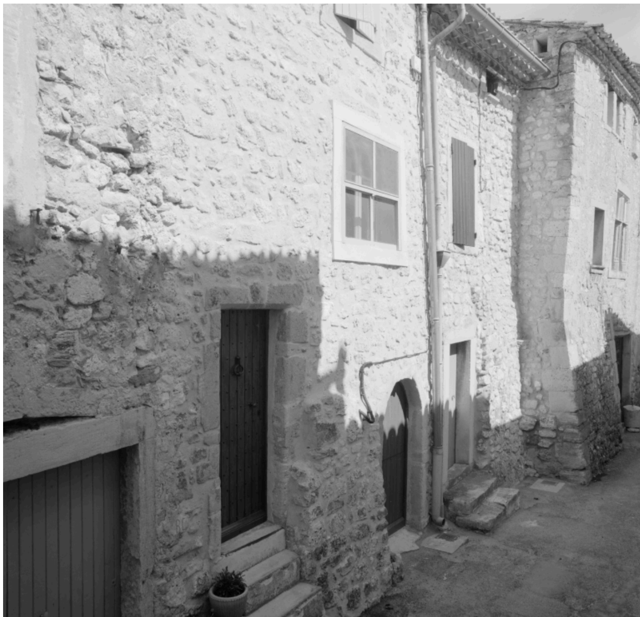
Maison (A 581), Grande rue, côté pair. Vue d'ensemble de la façade.
