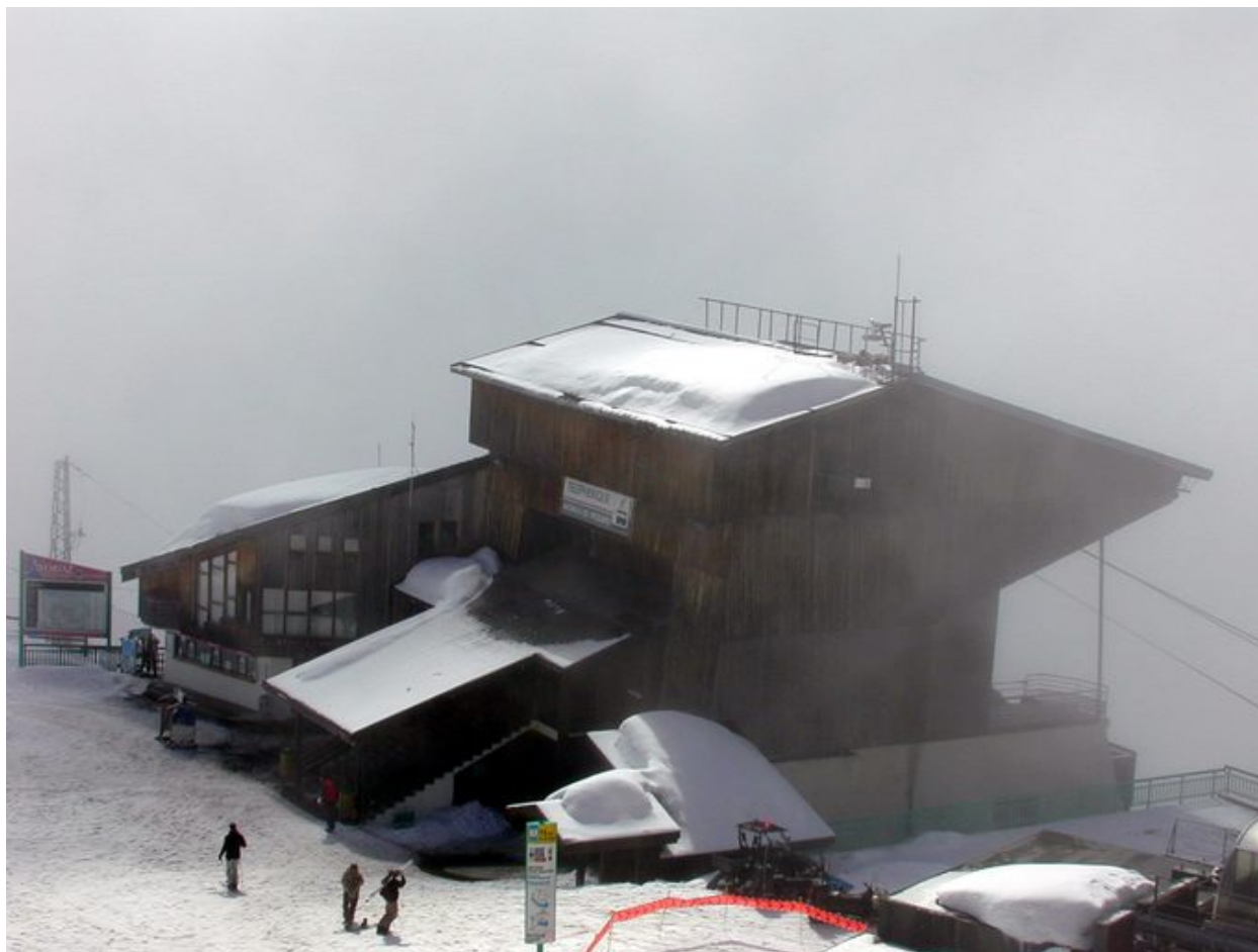
Vue depuis le nord-est
