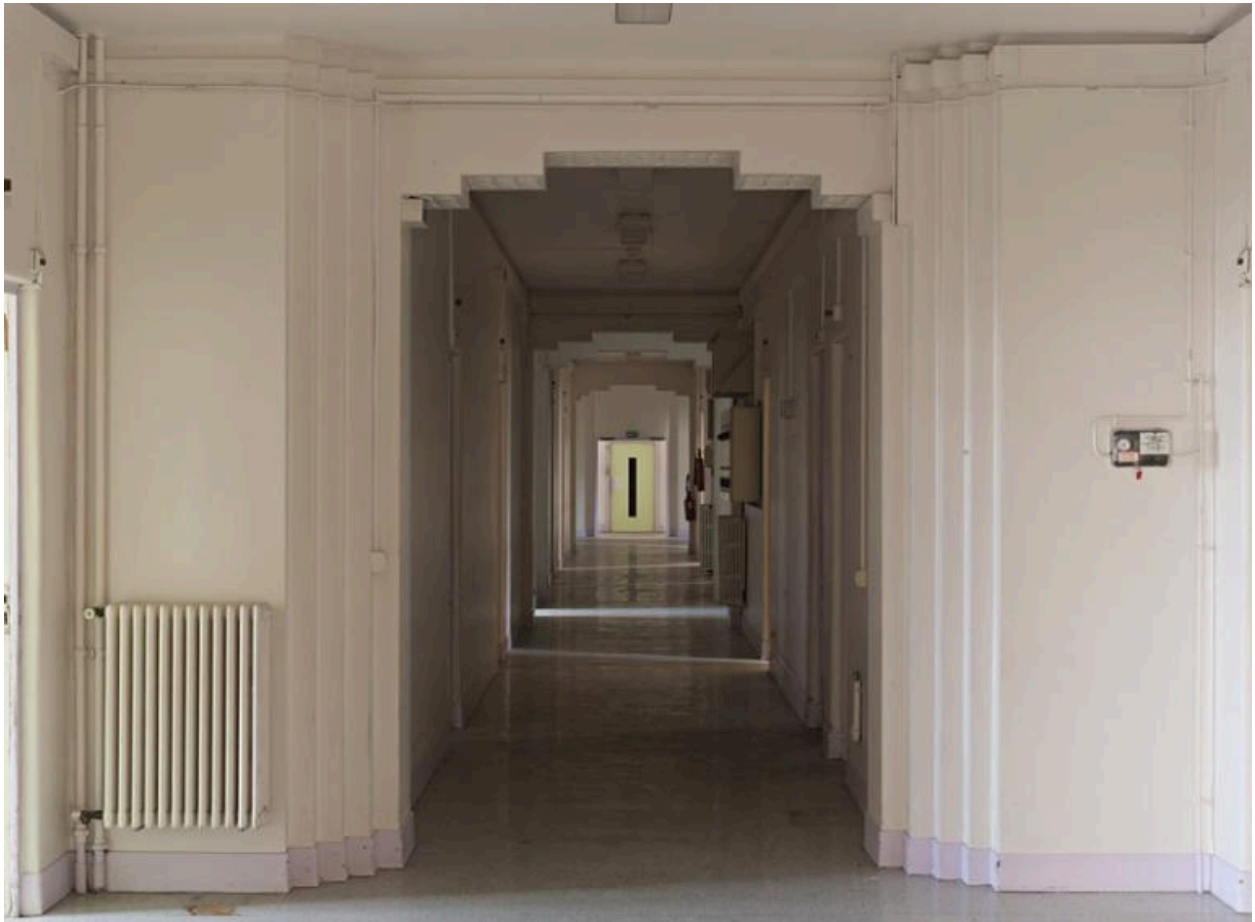
Hôtel-Dieu de Clermont-Ferrand. La polyclinique, moitié nord du couloir longitudinal du rez-de-chaussée (photographie prise depuis l'intersection centrale des couloirs).
