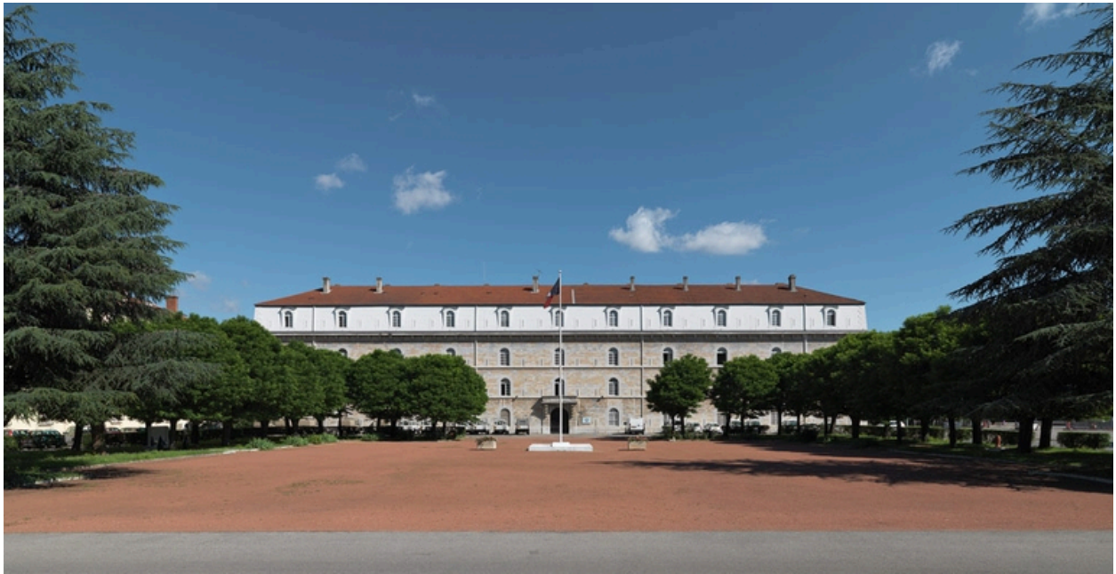
Bâtiment principal, façade est.
