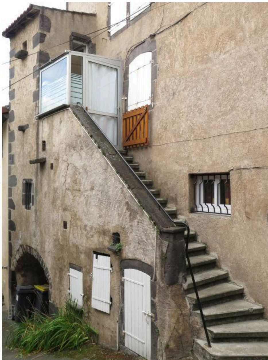
Escalier avec mur d'échiffre et parapet, parallèle à la façade : Blanzat, 20 passage des Sources
