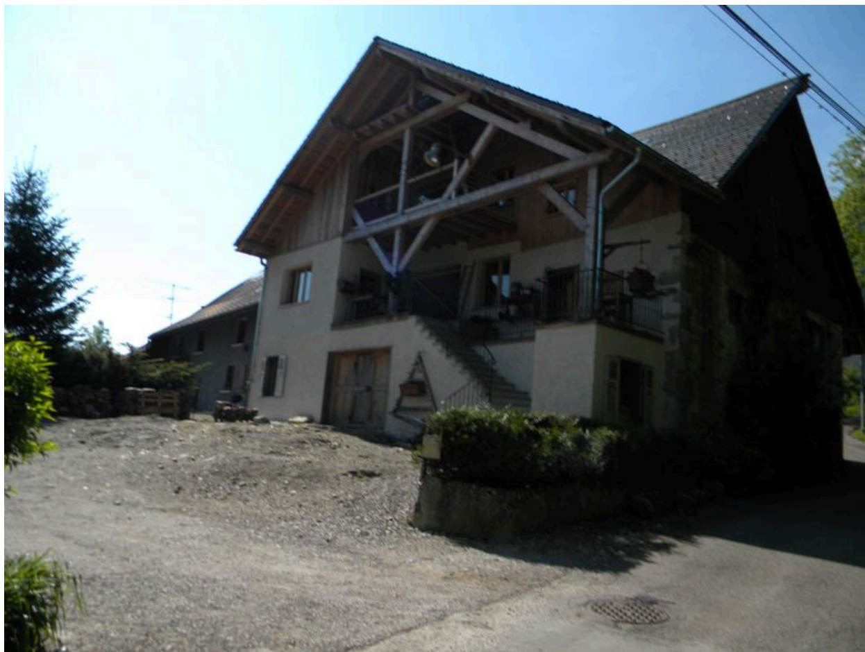
Vue de la façade nord avec l'extension contemporaine.
