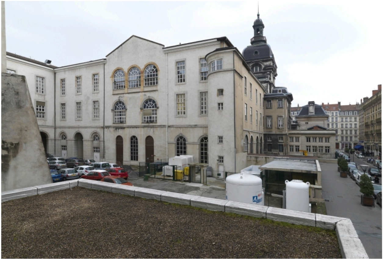
Bâtiment E. Vue d'ensemble depuis le nord-ouest
