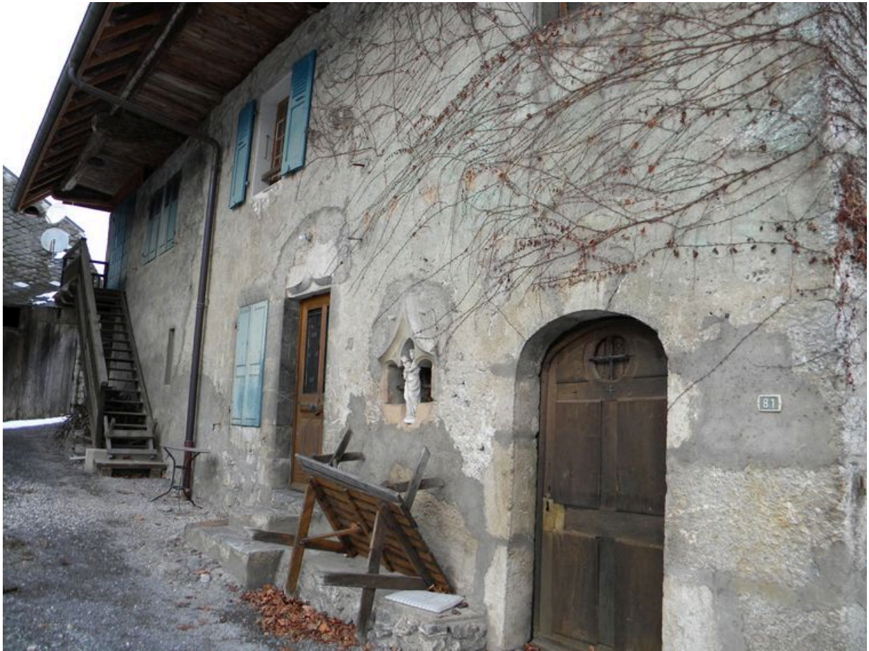
Vue de la façade principale avec entrée de cave au premier plan.
