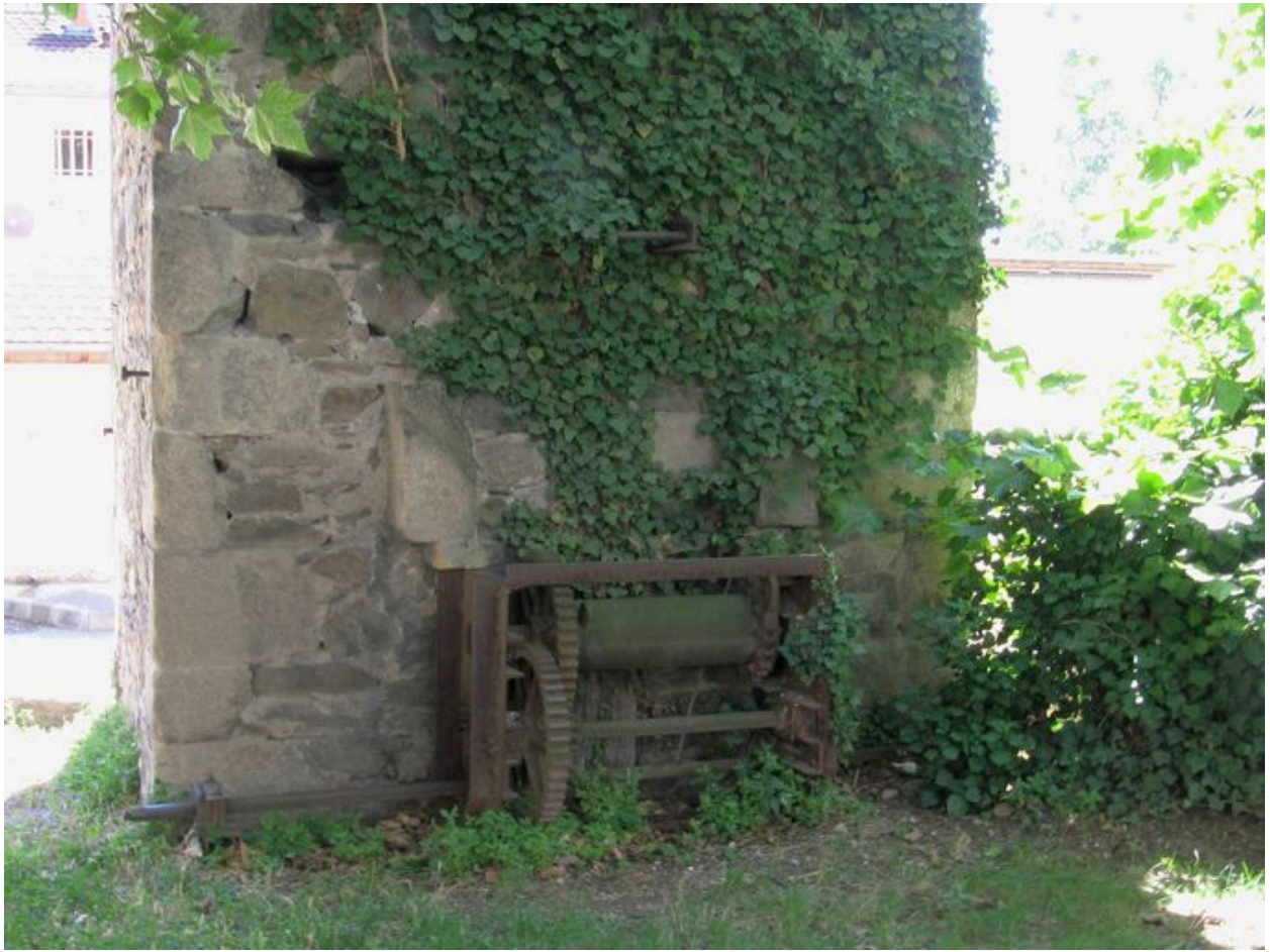
Vue de détail de la face ouest : treuil
