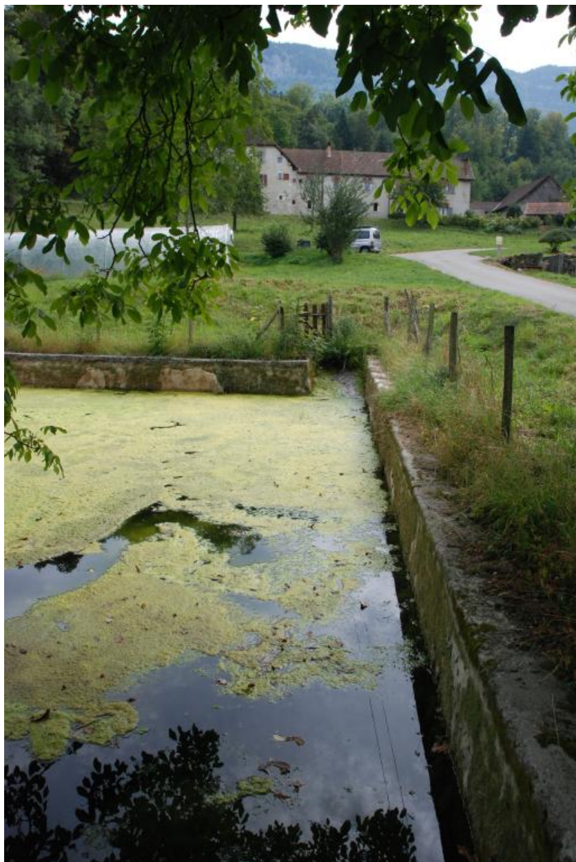
Vue d'ensemble du Bassin de Barraux
