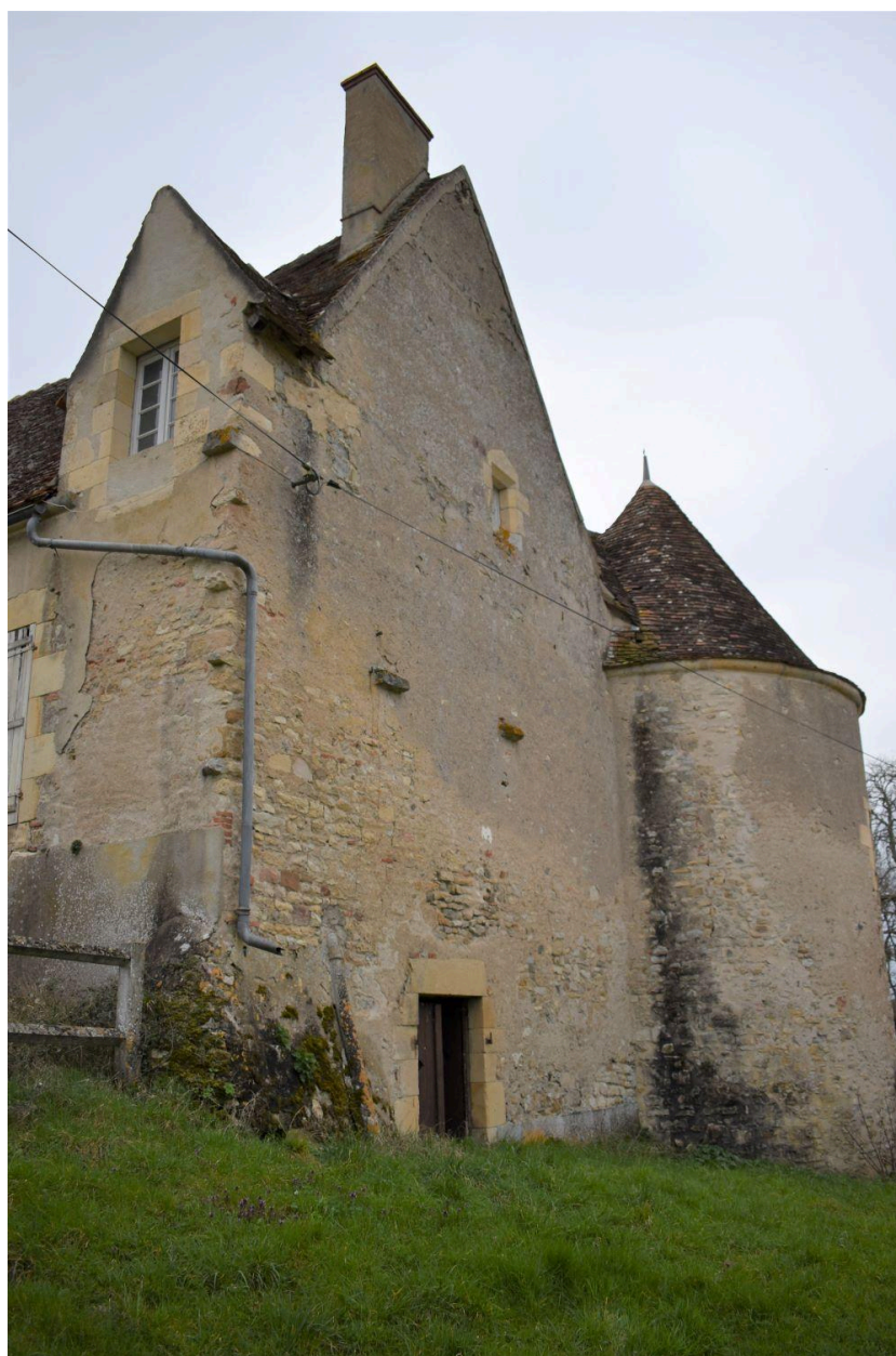
Ancien logis, vue du nord.
