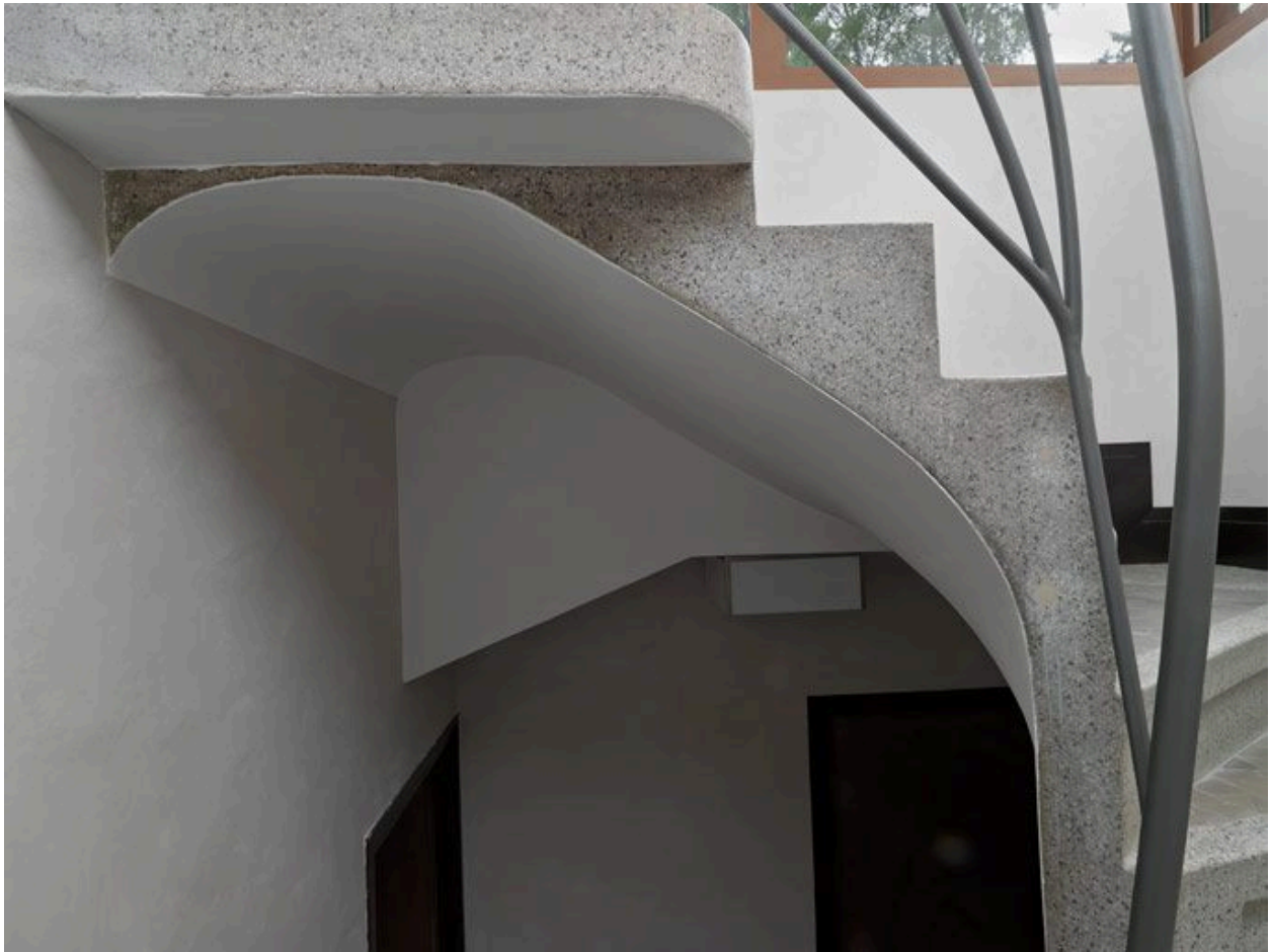
Détail sur l'escalier. Palier du 2e étage
