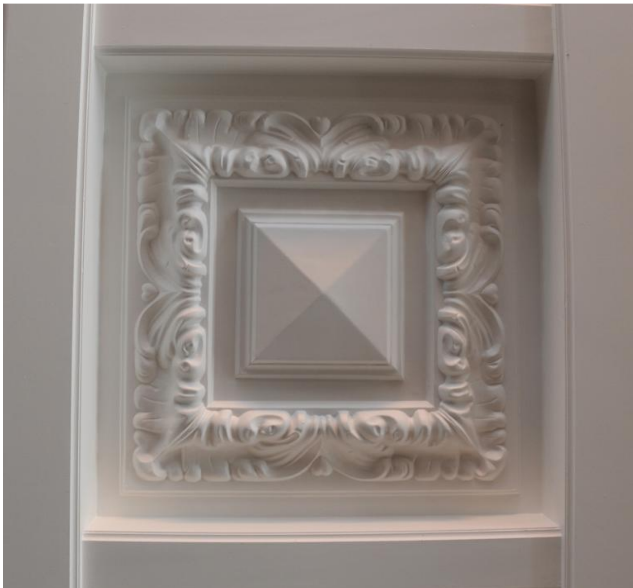
Détail du plafond à caissons
