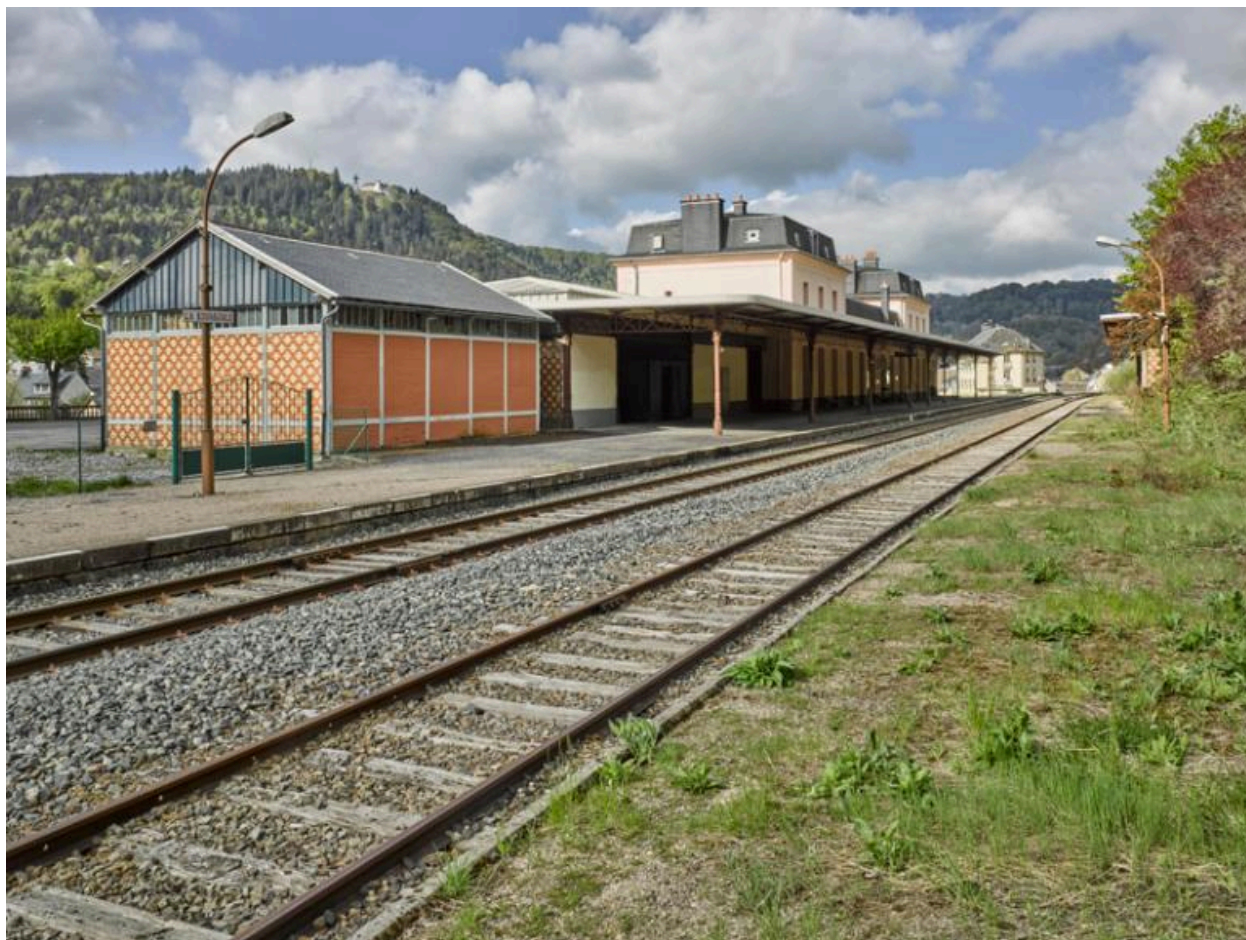
La gare de la Bourboule, côté voies.
