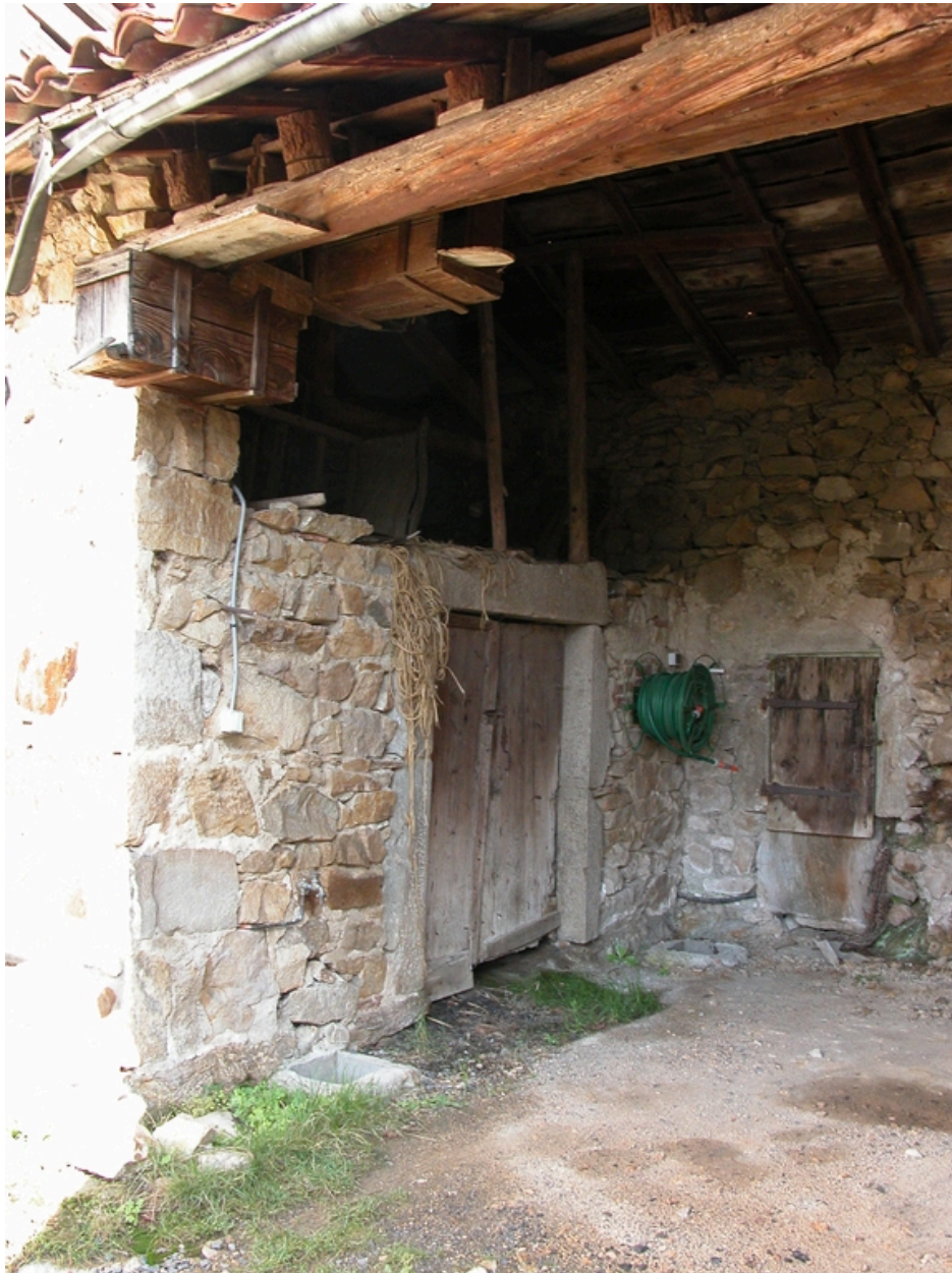
Vue du hangar et entrée de la cave.
