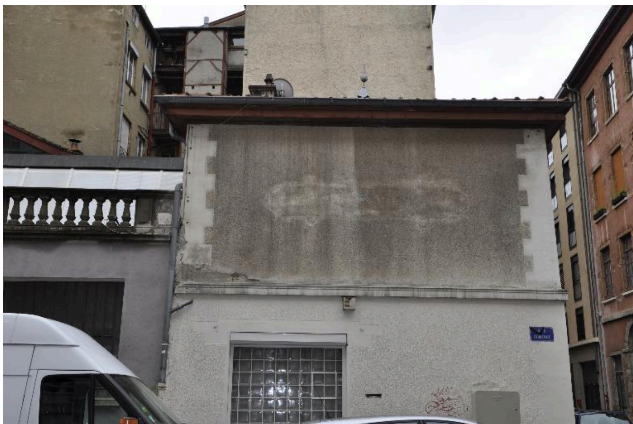
Marques d'une enseigne sur la façade rue Dumenge du n°16 rue du Pavillon
