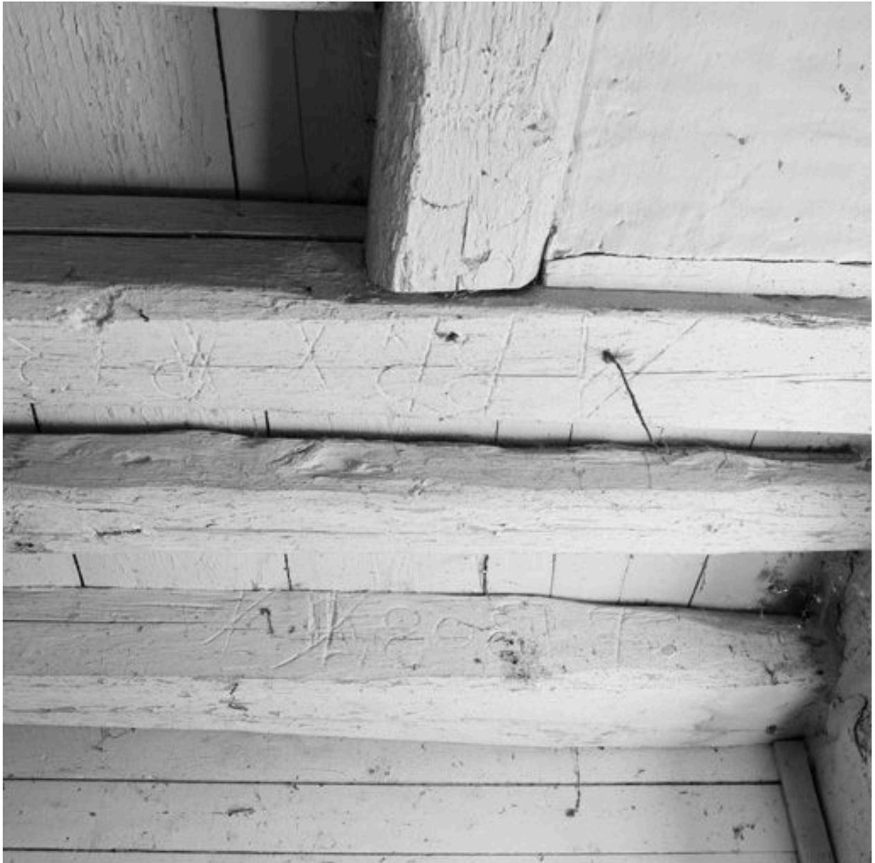
Corps de bâtiment ouest. Partie à droite de la tour d'escalier. Rez-de-chaussée. Marques de flottage du plafond à solives
