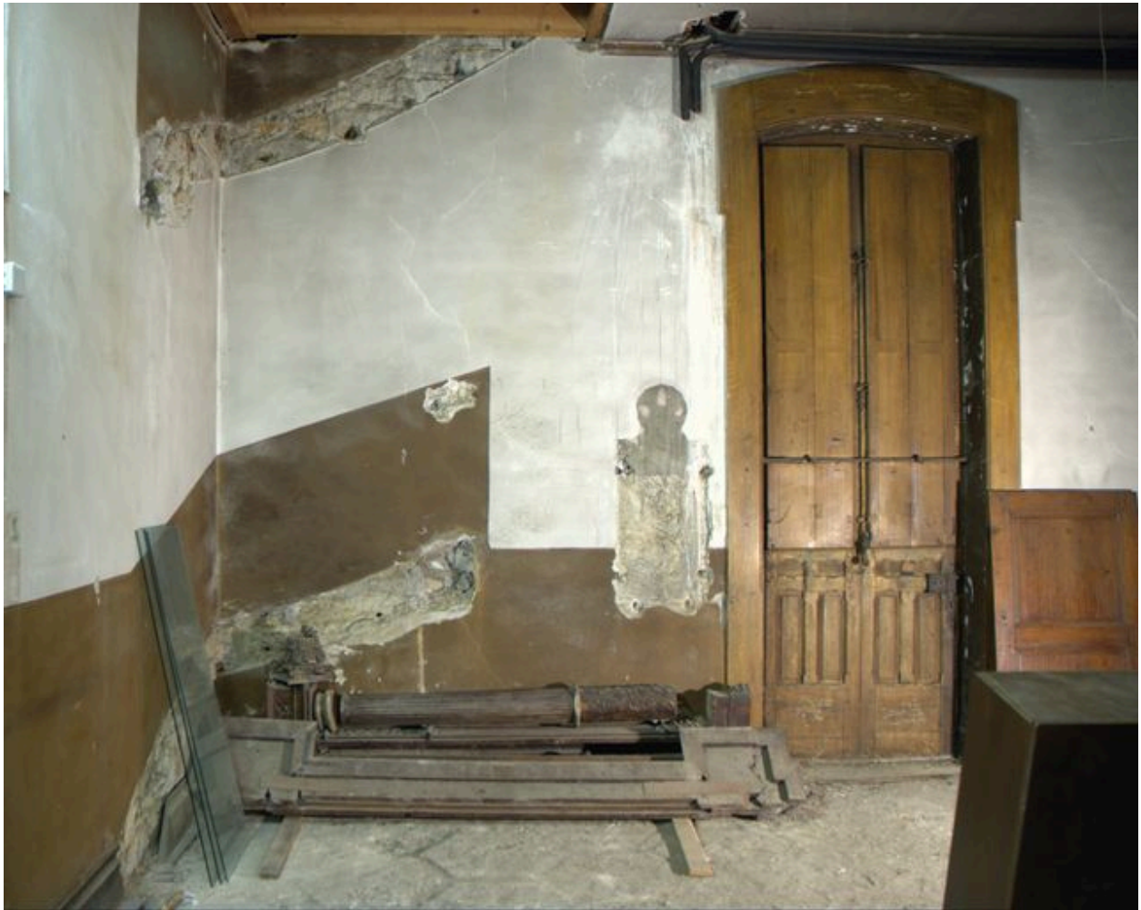
Sacristie extérieure, vue du mur ouest
