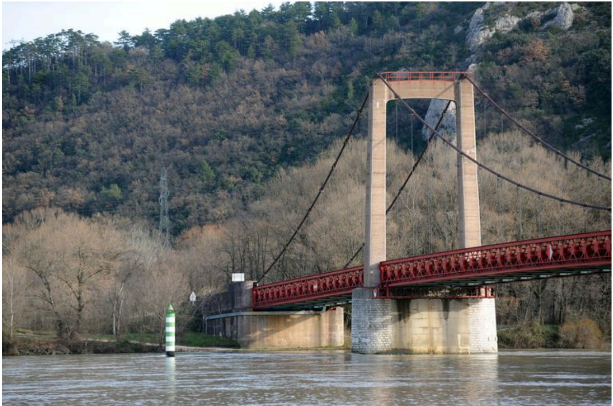
Vue partielle, culée et pile gauche, face amont (depuis la rive droite)
