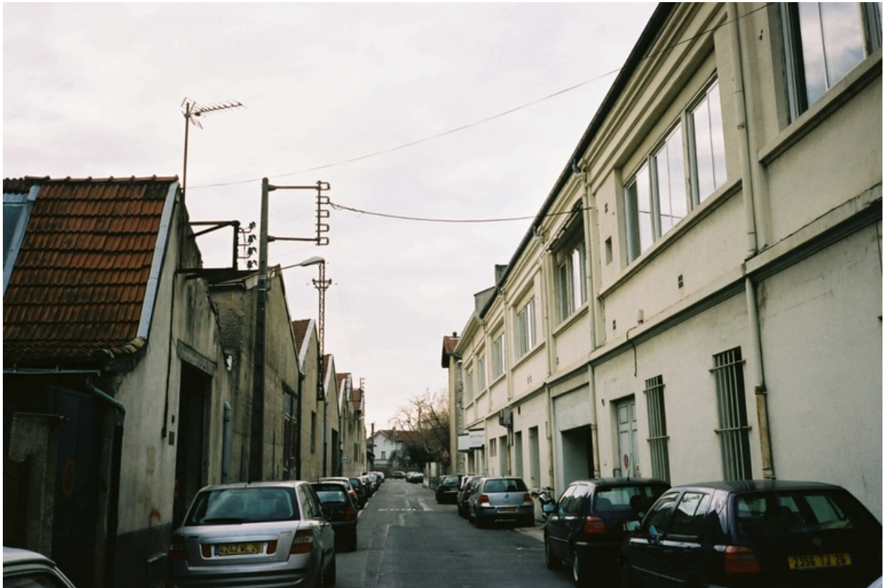
Vue générale nord du site, rue Pierre Curie
