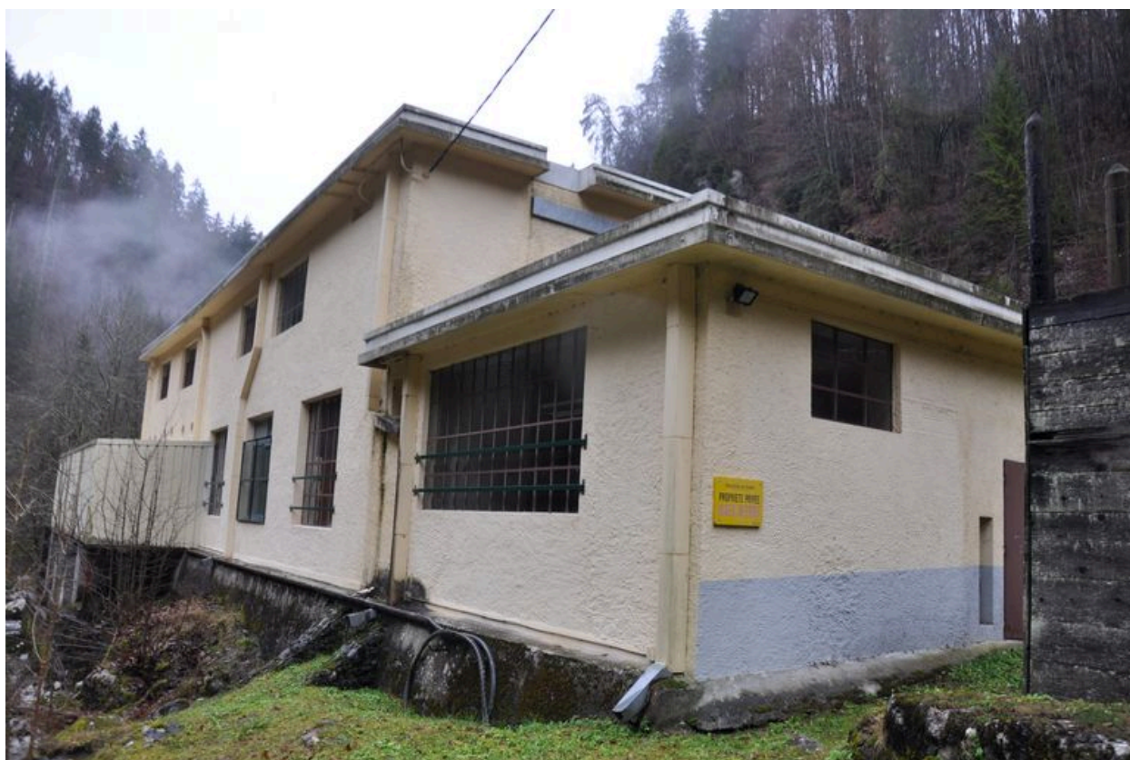
Élévation nord-est du bâtiment de la centrale
