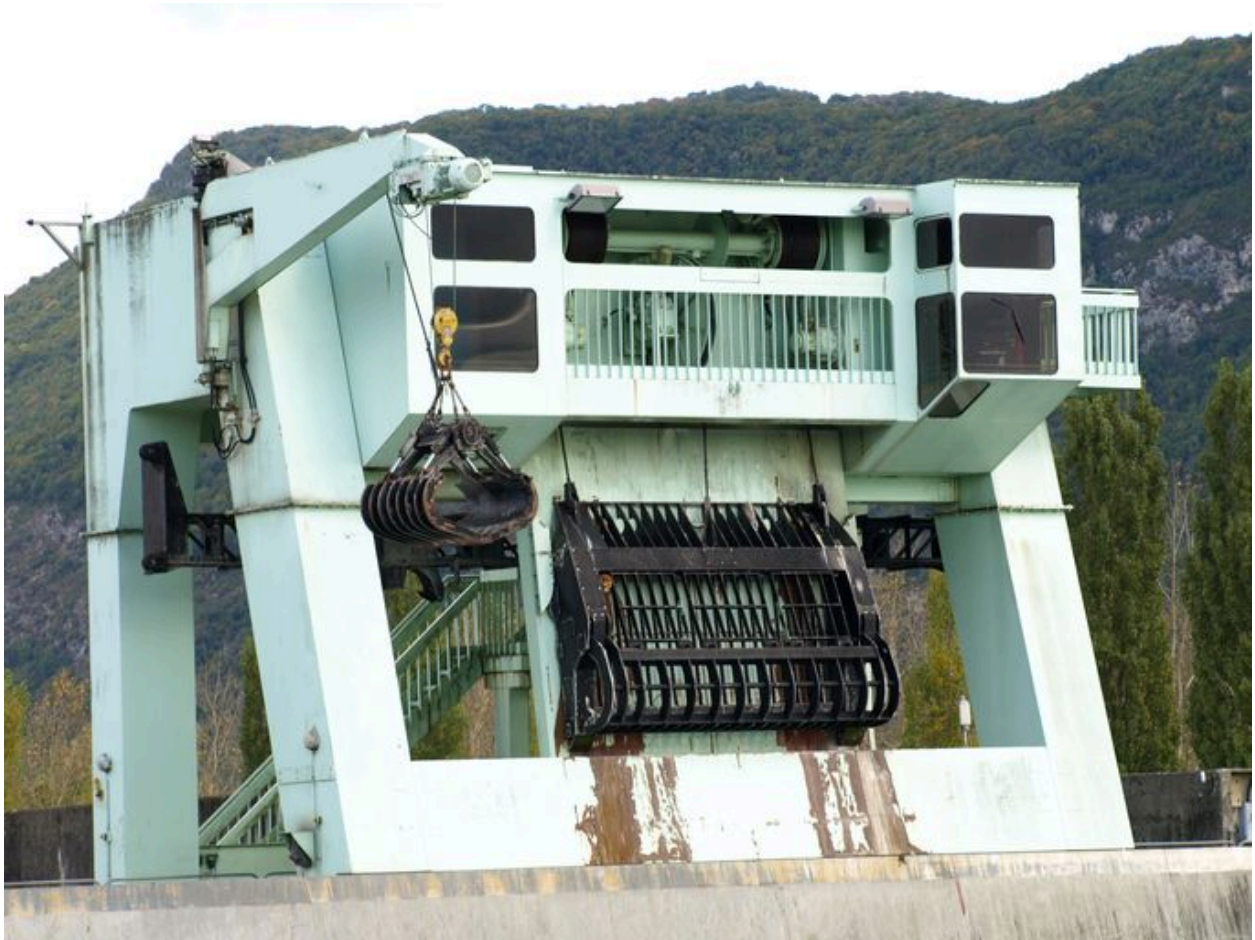
Machine, vue partielle amont (depuis la rive gauche)
